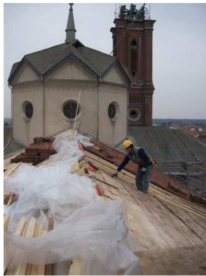
La copertura della navata centrale
